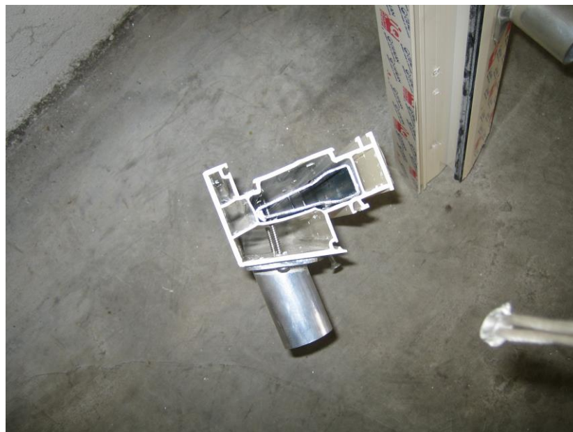
Foto 2: Mofconstructie gemonteerd op een schuinlopend kunststof profiel
