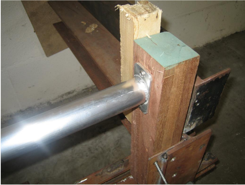
Foto 3: Doorvalbeveiliging gemonteerd tegen een houten kozijnprofiel
